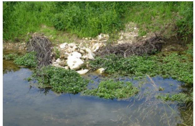
Abb. 10: Beispiel für den Einbau von Astbündeln kombiniert mit Wasserbausteinen im Bereich Göllingen
